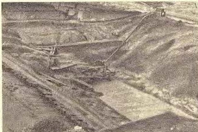
Fig. 4 și 5. — Transee experimentale cu taluze diferite și miră pentru observat variația nivelului apei.
