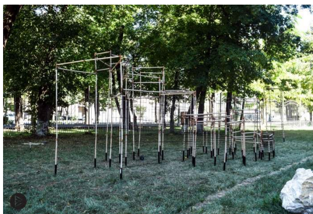
Structură din lemn și îmbinări din cupru în Lapidarium , MEDS, aug. 2016
